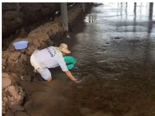
Bước 5: Trộn các vật liệu, phụ gia dùng để cứng hóa bùn nạo vét theo tỷ lệ thiết kế.
