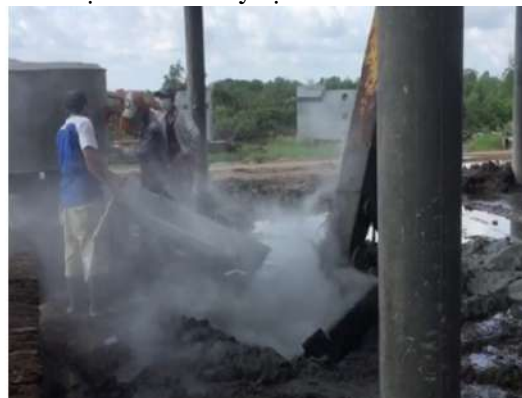
Bước 6: Rải phụ gia cứng hóa vào mặt bằng mô hình cứng hóa đã chuẩn bị trước.
