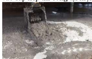
Bước 7: Sử dụng thiết bị trộn có gắn gầu mức cải tiến của Viện Thủy công để trộn bùn + phụ gia cứng hóa. Thi công theo các ô đã phân chia tùy thuộc vào sắp xếp thi công tại hiện trường.
