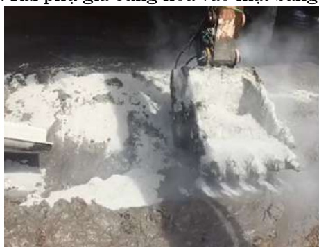
Bước 7: Sử dụng thiết bị trộn có gắn gầu mức cải tiến của Viện Thủy công để trộn bùn + phụ gia cứng hóa. Thi công theo các ô đã phân chia tùy thuộc vào sắp xếp thi công tại hiện trường.
