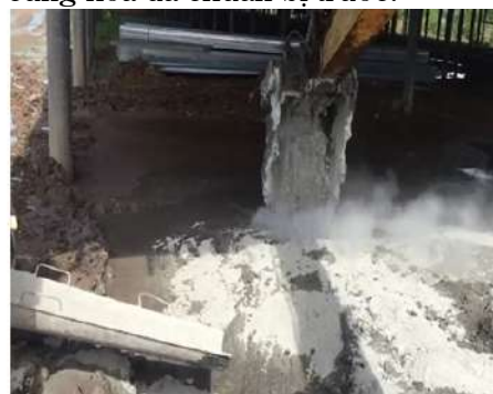
Bước 7: Sử dụng thiết bị trộn có gắn gầu mức cải tiến của Viện Thủy công để trộn bùn + phụ gia cứng hóa. Thi công theo các ô đã phân chia tùy thuộc vào sắp xếp thi công tại hiện trường.
