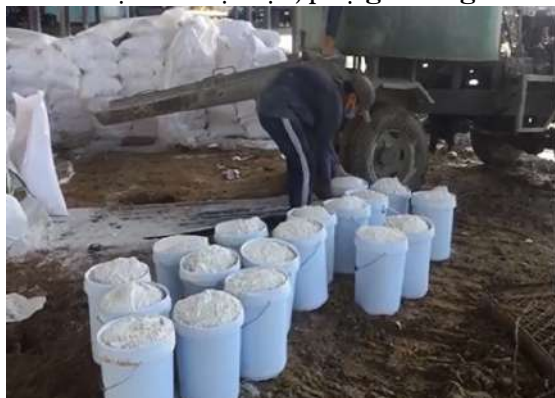
Bước 6: Rải phụ gia cứng hóa vào mặt bằng mô hình cứng hóa đã chuẩn bị trước.
