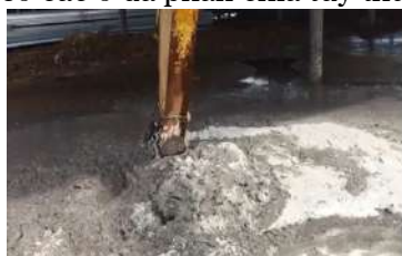
Bước 7: Sử dụng thiết bị trộn có gắn gầu mức cải tiến của Viện Thủy công để trộn bùn + phụ gia cứng hóa. Thi công theo các ô đã phân chia tùy thuộc vào sắp xếp thi công tại hiện trường.
