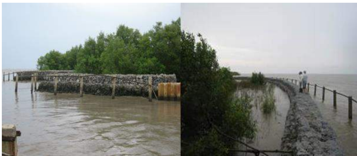
Hình 6: Kè chống sạt lở bằng rọ đá kết hợp cọc BTCT, cống Hương Mai [4]
