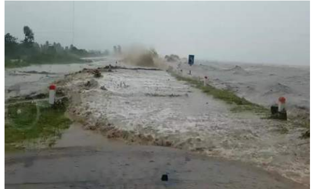
Hình 2: Triều cường kết hợp với sóng to, gió lớn làm nước biển tràn qua đê biển Tây vào ngày 03/8/2019 [5]
