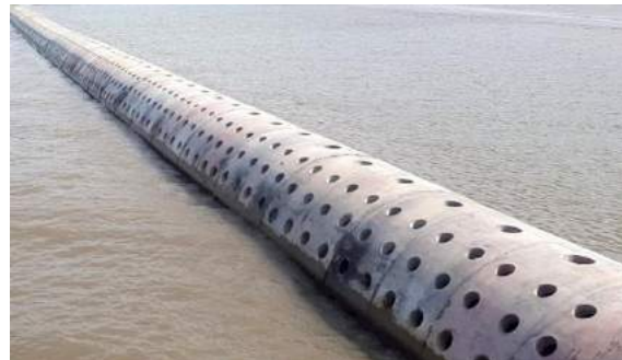
Hình 10: Tuyến đê trụ rỗng giảm sóng tại biển Tây tỉnh Cà Mau [5]
