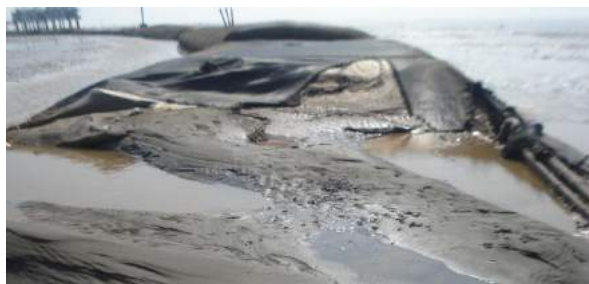
Hình 5: Đê giảm sóng bằng túi Geotube tại Bạc Liêu [4]
