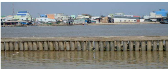
Hình 9: Kết cấu đê giảm sóng hai hàng cọc ly tâm [4]
