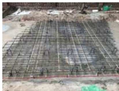
Hình 3: Một số hình ảnh xây dựng khối bê tông chứa khuyết tật
