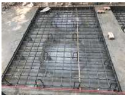
Hình 3: Một số hình ảnh xây dựng khối bê tông chứa khuyết tật
