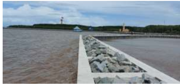
Hình 2: Kết cấu đê giảm sóng hai hàng cọc ly tâm
