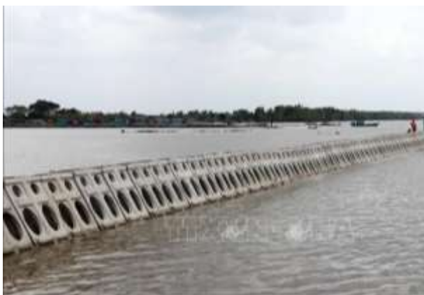
Hình 3: Cầu kiện đề xuất của Busadco đề xuất ở biển Tây
