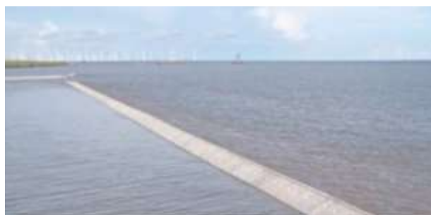
Hình 5: Tuyến đê trụ rỗng giảm sóng tại biển Đông tỉnh Bạc Liêu
