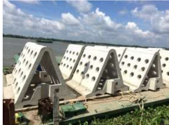
Hình 7: Đê giảm sóng kết cấu rỗng (TC1, TC2)
