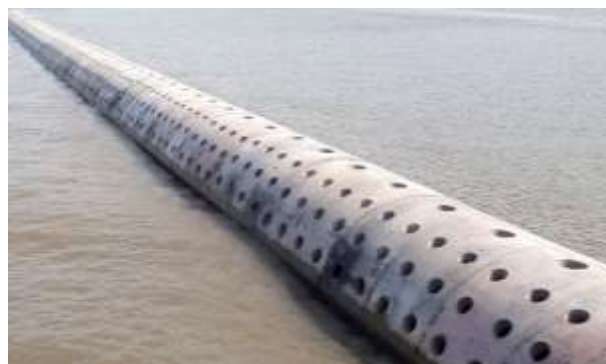
Hình 6: Tuyến đê trụ rỗng giảm sóng tại biển Tây tỉnh Cà Mau
