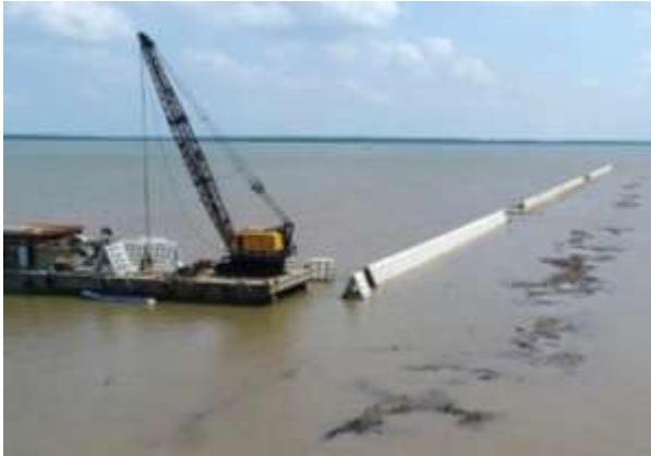
Hình 7: Đê giảm sóng kết cấu rỗng (TC1, TC2)
