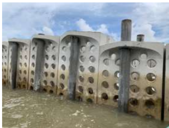
Hình 4: Cầu kiện đề xuất của Busadco đề xuất ở biển Đông
