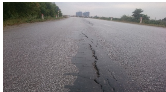
Hình 4. Đê Tả Hồng - Hưng Yên đoạn km 81 ÷ km 100
