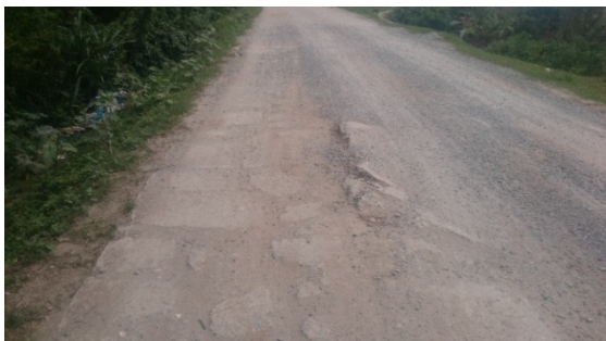
Hình 3. Đê Hữu Hồng - Hà Nam đoạn km 129,5 ÷ km 136, khảo sát 4/2018
