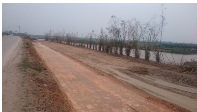
Hình 7. Thi công mở rộng đê phía thượng lưu, tạo lề đường để xử lý sự cố lún nứt mặt đê đoạn km 81 ÷ km 100 đê Tạ Hồng – Hưng Yên
