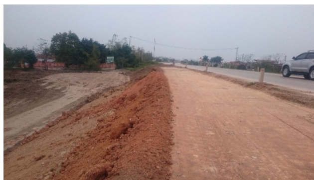
Hình 7. Thi công mở rộng đê phía thượng lưu, tạo lề đường để xử lý sự cố lún nứt mặt đê đoạn km 81 ÷ km 100 đê Tạ Hồng – Hưng Yên
