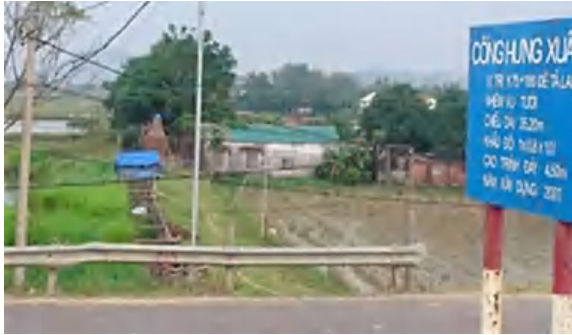
Hình 7: Kênh dẫn BTCT phía đông
