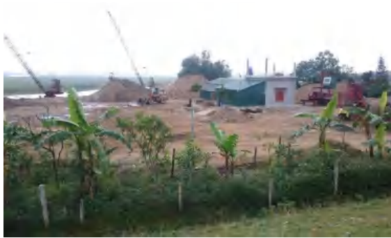
Hình 9: Bãi tập kết vật liệu phía sông
