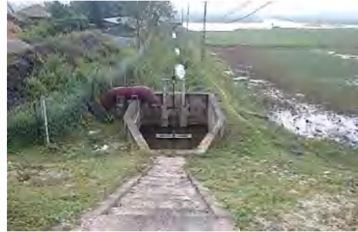
Hình 8: Bể xả và kênh dẫn phía sông
