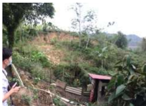
Hình 19: Trượt lở sườn dốc khu tái định cư tỉnh Điện Biên
