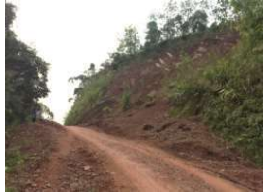
Hình 8: Trượt lở mái ta luy phải đường từ Nậm Tăm đi bản Nậm Ngập 1
