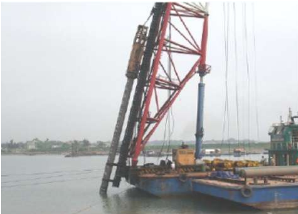
Hình 5: Đóng hạ cọc bằng tàu đóng cọc và búa treo
