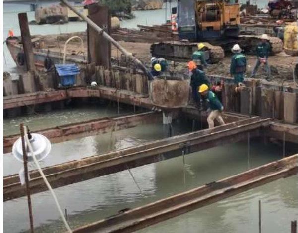
Hình 12: Đổ bê tông bịt đáy
