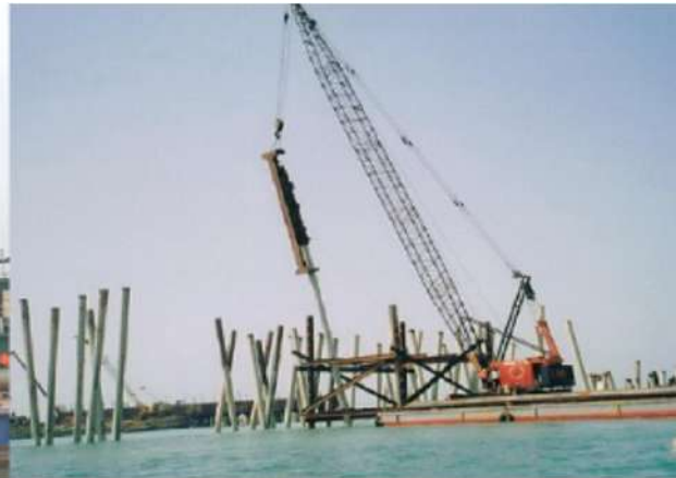
Hình 5: Đóng hạ cọc bằng tàu đóng cọc và búa treo
