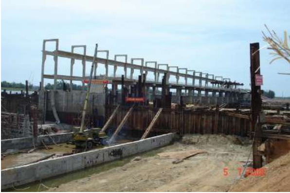
Hình 3: Thi công công Đò Diệt bằng khung vây cọc ván thép 2 lớp
