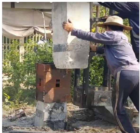
Hình 10: Lắp đặt hộp nổi cọc
