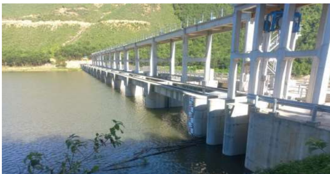
Hình 3: Đập dâng nước Hòa Liên
