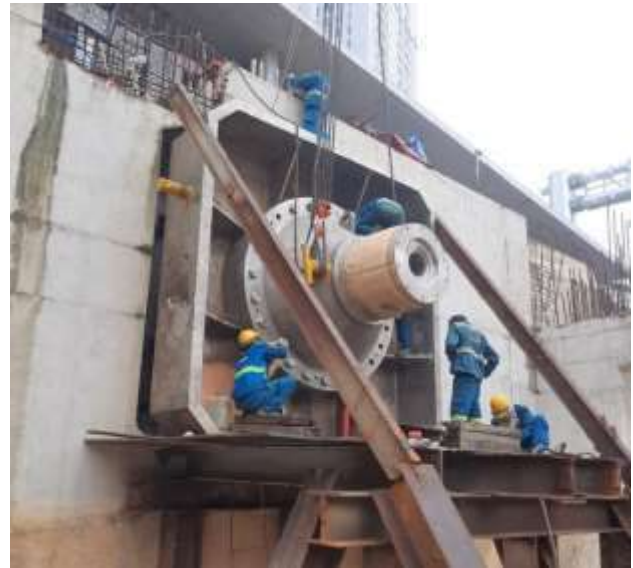
Hình 11: Cấu tạo và lắp đặt cụm cối quay cửa
