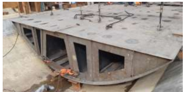
Hình 8: Lắp đặt khối bản mặt
