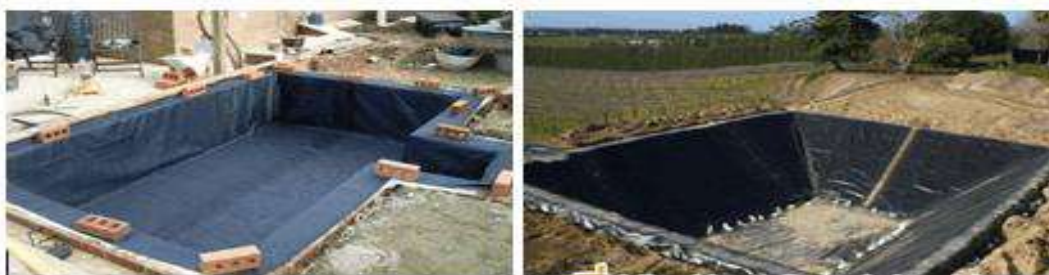
Hình 8: Mô hình trữ nước ngọt bằng bể chìm đa vật liệu đất quy mô nhỏ lẻ ở các hộ gia đình
