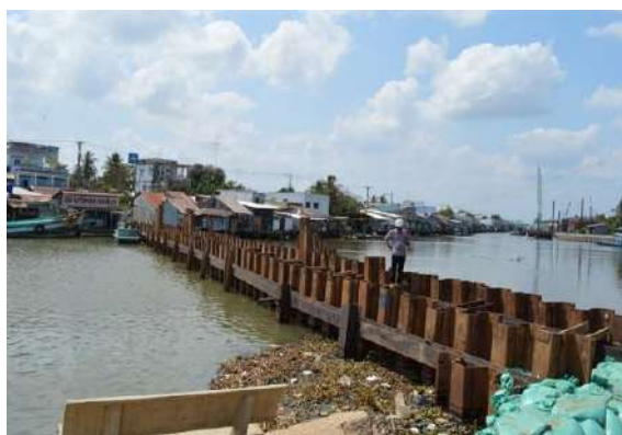
Hình 9: Mô hình trữ nước ngọt bằng ngăn các đoạn sông, kênh ít tàu thuyền qua lại bằng đập tạm
