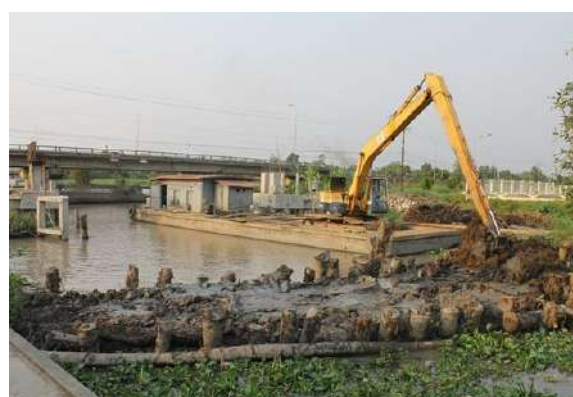
Hình 9: Mô hình trữ nước ngọt bằng ngăn các đoạn sông, kênh ít tàu thuyền qua lại bằng đập tạm
