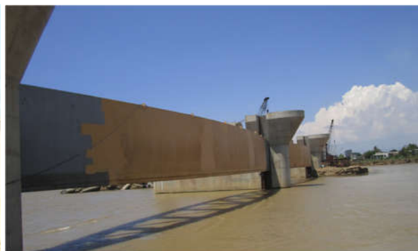
Hình 4 - Công trình Đập hạ lưu sông Dinh (Ninh Thuận) năm 2018, gồm 6 khoang x 37,8m, cao 3,7m.
