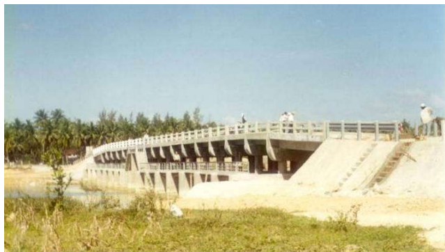
Hình 3 - Công trình cống Hiền Lương (Quảng Ngãi), năm 2000, gồm 16 khoang x 4.0m, cao 4.0m
