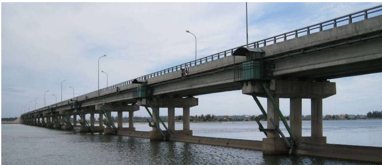
Hình 2. Công trình đập Thảo Long (Thừa Thiên Huế) hoàn thành năm 2008 (gồm: 15 khoang x 31,5m)
