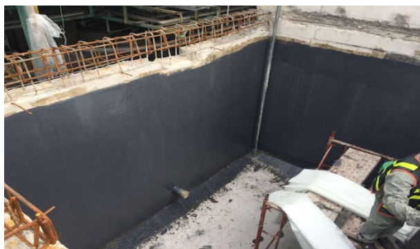
Hình 2.6: Bể chứa bê tông cốt thép
