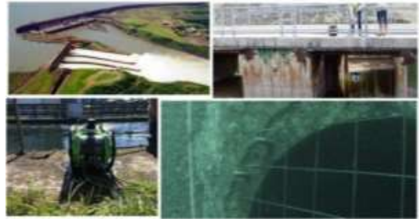
Hình 9: Kiểm tra công đập Hydro Quebec dùng ROV- Seabotix tại Canada
