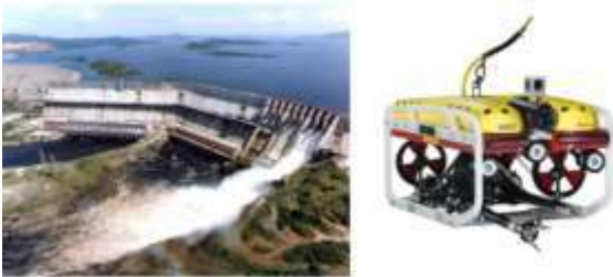
Hình 8: Đập thủy lợi Guri và FALCON ROV được sử dụng cho việc khảo sát
