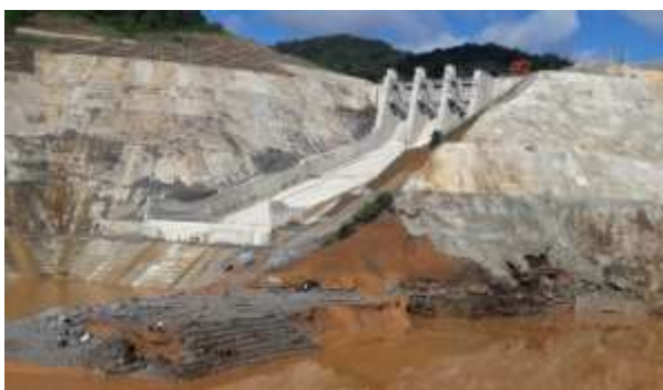
Hình 1: Thủy điện Đa Krong 3 (Quảng Trị) xảy ra sự cố vỡ thân đập trước khi phát điện
