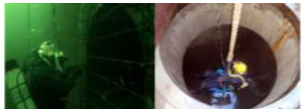
Hình 4: Thợ lặn kiểm tra hệ thống cống tại đê, đập thủy lợi
