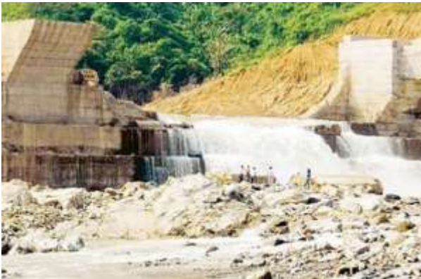
Hình 1: Thủy điện Đa Krong 3 (Quảng Trị) xảy ra sự cố vỡ thân đập trước khi phát điện
