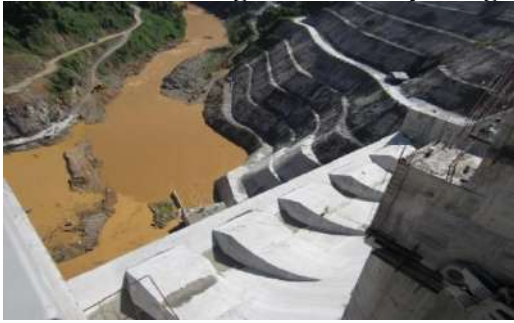
Ảnh 7: Tràn sông Bung 4 đang xây dựng
