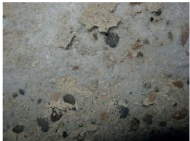
Hình 4: Các mảng bê tông bị mất tính chất cơ học, bị tách rời ra khỏi công trình do thaumasite
