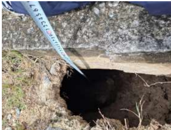
Hình 7: Hình ảnh các hố sụt tại mái hạ lưu đập năm 2025
