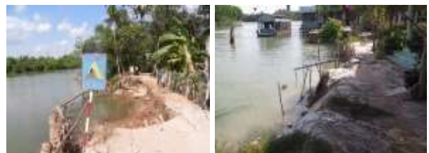
Hình 2: Hiện trạng sạt lở đặc biệt nguy hiểm khu vực kênh Mái Dầm, huyện Châu Thành
