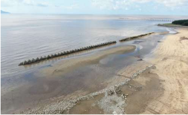
Hình 15. Hiệu quả giảm sóng gây bồi của công trình sau khi được hoàn thiện [12]
