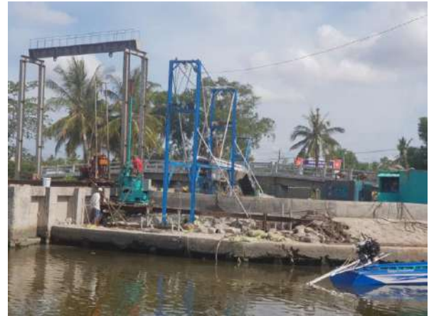
Hình 2. Xử lý cống đập xả lan ở tỉnh Cà Mau bằng khoan phụt Silicate
