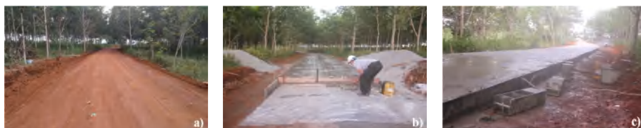
Hình 5: Một số hình ảnh thi công mô hình thử nghiệm. a) Lu phẳng bề mặt nền đường; b) Trải nilon, lắp ván khuôn; c) Đầm, san gạt và tạo phẳng bề mặt
