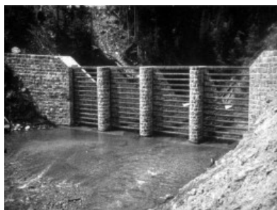
b) Đập chắn tường trụ pin và dầm, Maerzenbach, Tyrol, Áo
