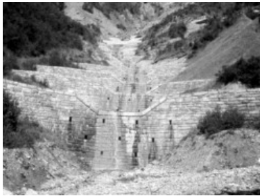
a) Ổn định độ dốc lòng dẫn, Bretterwandbach, Tyrol, Áo.
