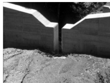
c) Đập chắn khe dọc, Zinkenbach, Salzburg, Áo
