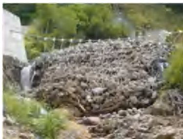
d) Lưới cáp chắn dòng bùn đá tại núi Tateyama, Nhật Bản. Một phần của dây (trái) đã bị cắt bởi những tảng đá.
