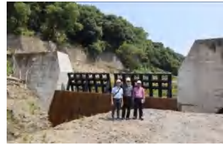
c) Đập kín cải tạo thành đập nửa kín nửa hở, tác giả chụp tại Kyushu Nhật Bản 7/2019
