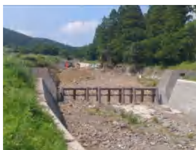
e) Đập hở kết hợp bể chứa bùn đá tại Kyushu, Nhật Bản (tác giả chụp 7/2019)
