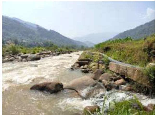
Hình 2.3: Kênh dẫn nước sau đập dâng Bản Hát (Trạm Tấu, Yên Bái) bị phá hủy gần như hoàn toàn do lũ bùn đá và phải thay thế bằng ống nhựa
