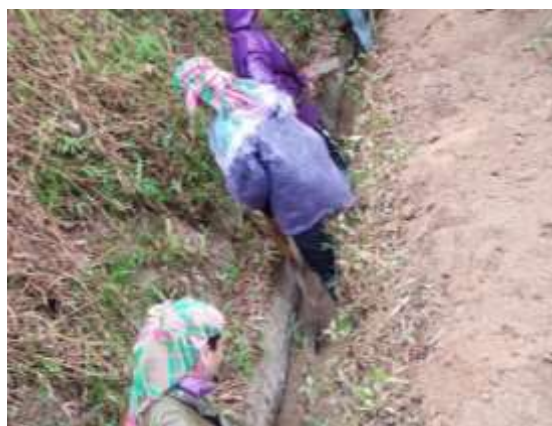
Hình 2.4: Lắp tắc kênh dẫn nước sau đập dâng Nậm Khắt (xã Dương Quỳ, Văn Bàn, Lào Cai)
