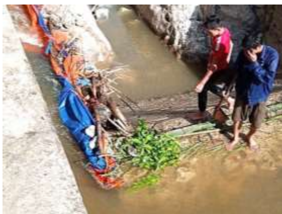
Hình 2.4: Lắp tắc kênh dẫn nước sau đập dâng Nậm Khắt (xã Dương Quỳ, Văn Bàn, Lào Cai)
