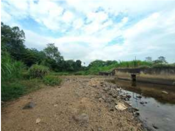
Hình 2.2: Bồi lấp đầu mối đập dâng xã Tú Sơn nhìn từ thượng lưu đập (Kim Bôi, Hòa Bình)
