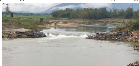
Hình 6. Đập tạm Quảng Huế
