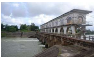
Hình 2. Đập dâng An Trạch
