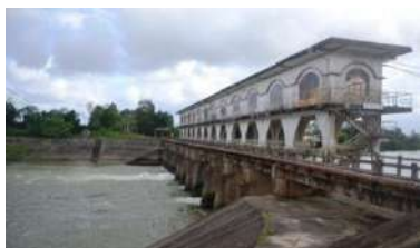
Hình 2. Đập dâng An Trạch
