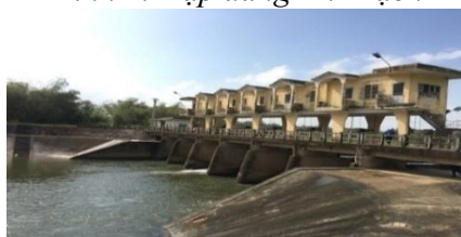
Hình 5. Đập dâng Bàu Nít
