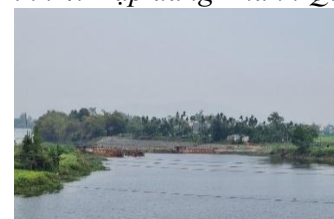
Hình 7. Đập tạm Tứ Câu
