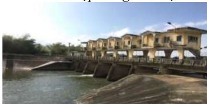
Hình 7. Đập dâng Bàu Nít
