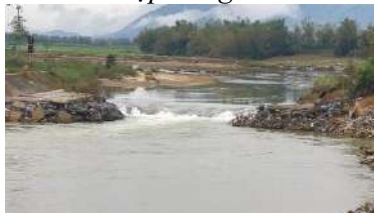
Hình 8. Đập tạm Quảng Huế
