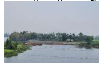
Hình 9. Đập tạm Tứ Câu
