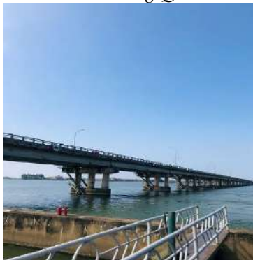
Hình 5. Đập Tháo Long đang vận hành mở cửa van
