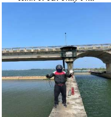
Hình 4. Đập Thảo Long
