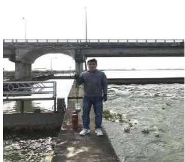
Hình 4. Đập Thảo Long
