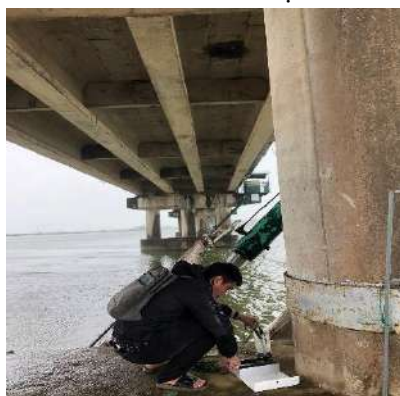
Hình 4. Đo mặn Đập Thảo Long
