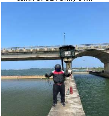
Hình 4. Đập Thảo Long
