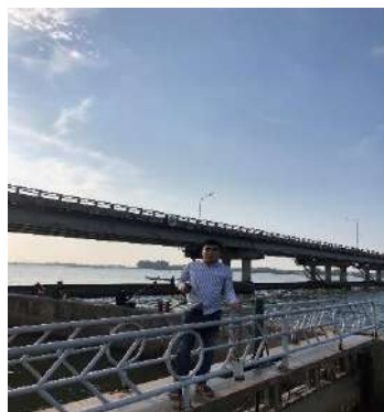
Hình 1. Đập Thảo Long
