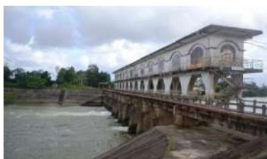
Hình 2. Đập dâng An Trạch
