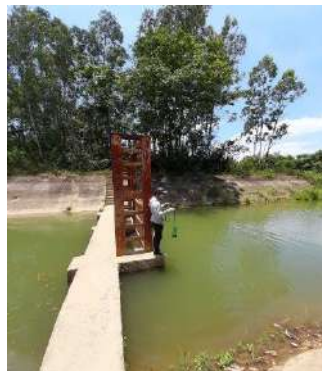
Hình 5: Trạm bơm Đông Quang
