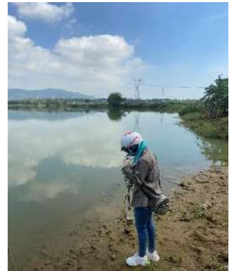
Hình 3: Trạm bơm Miếu Ông
