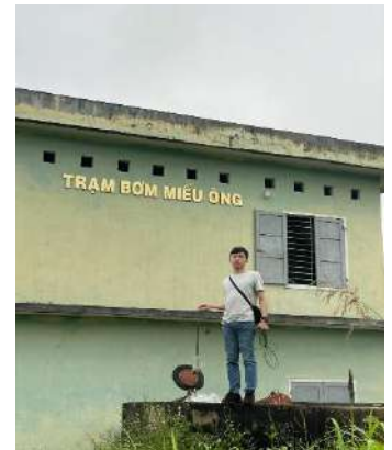
Hình 3. Trạm bơm Miếu Ông
