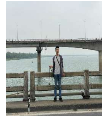
Hình 6. Cầu Câu Lâu
