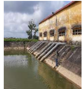
Hình 4: Trạm bơm Bích Bắc
