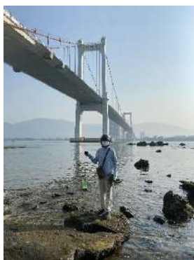
Hình 1. Cầu Thuận Phước
