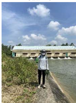
Hình 5. Trạm bơm Đông Quang
