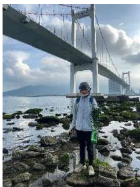
Hình 1. Cầu Thuận Phước
