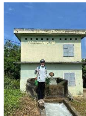
Hình 3. Trạm bơm Miếu Ông
