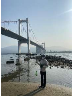
Hình 1. Cầu Thuận Phước
