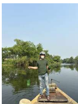
Hình 4. Trạm bơm Tuý Loan
