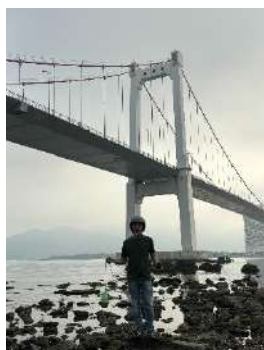
Hình 1. Cầu Thuận Phước
