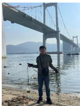
Hình 1. Cầu Thuận Phước
