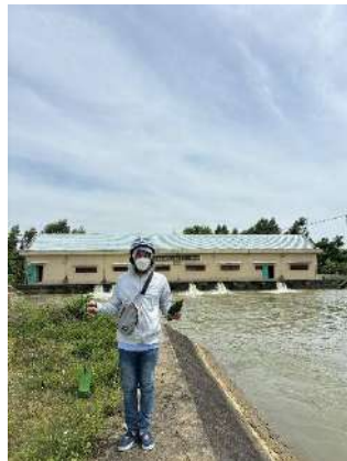
Hình 5. Trạm bơm Đông Quang
