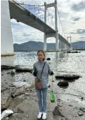
Hình 1. Cầu Thuận Phước
