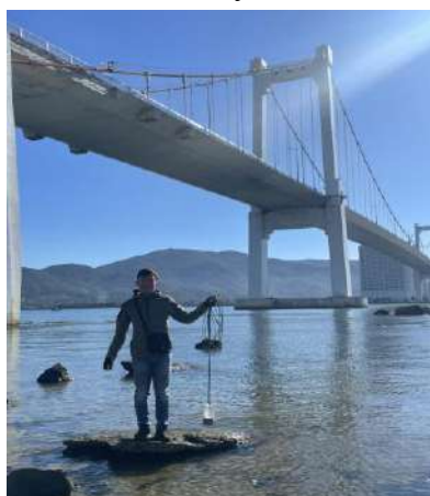
Hình 1. Cầu Thuận Phước
