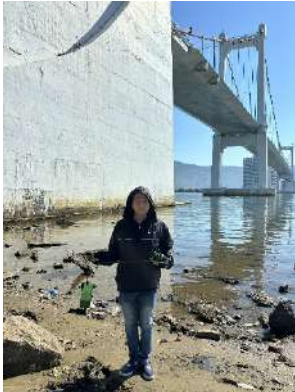
Hình 1. Cầu Thuận Phước
