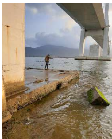
Hình 1. Cầu Thuận Phước
