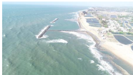
Hình 3.74: Thực tế thi công mô hàn dạng chữ T và 02 phân đoạn đê ngầm phía Bắc
