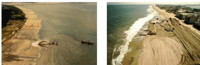
Hình 3.80: Bảo vệ bờ biển bằng giải pháp bù cát (nuôi bãi nhân tạo)
