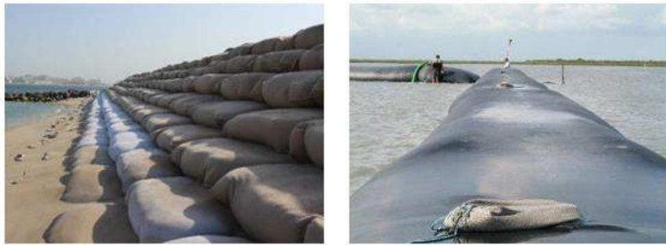
Hình 3.82: Vật liệu bảo vệ bờ dùng bao tải (trái) và ống cát GST (phải)
