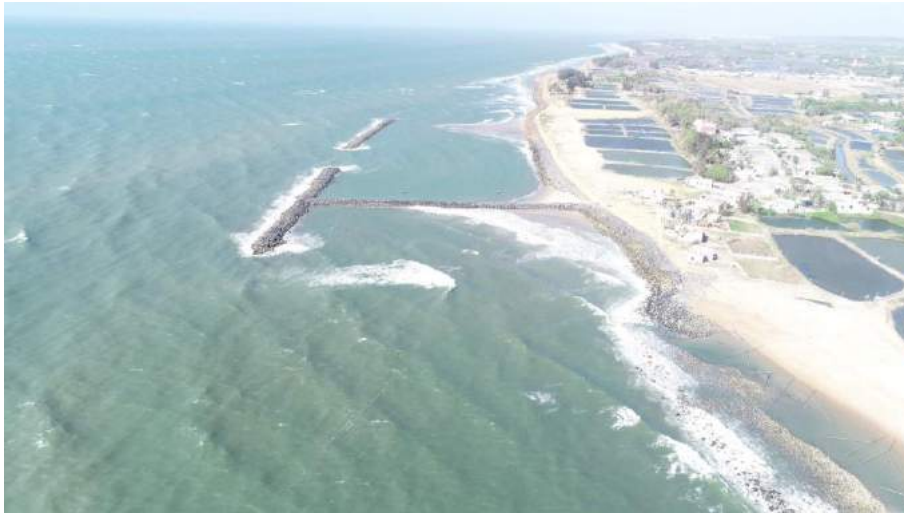
Hình 3.74: Thi công hoàn chỉnh mô hàn và 02 phân đoạn đê ngầm phía Bắc 7
