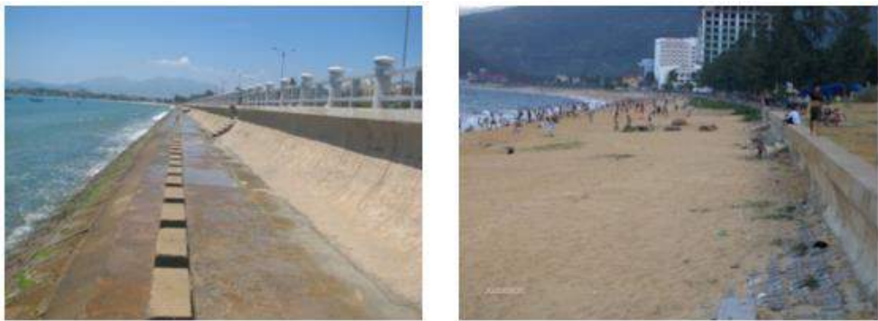
Hình 3.83: Kè biển dạng kết hợp ở Nha Trang (trái) và Quy Nhơn (phải)
