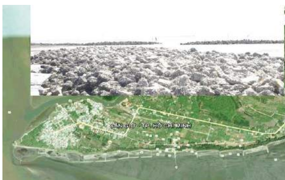
Hình 3.70: Hệ thống mỏ hàn và đê giảm sóng bảo vệ bờ biển Cần Giờ - Tp. HCM
