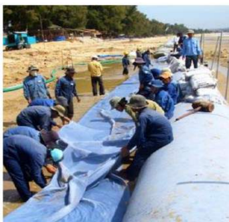
Hình 3.79: Thực trạng thi công Stabiplate tại Đồi Dương – Phan Thiết.
