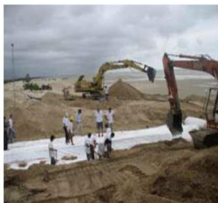
Thi công lắp đặt geotube
