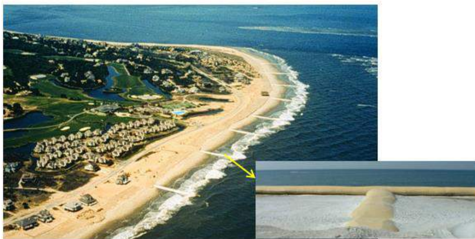
Hình 3.87: Tổng thể công trình kè mỏ hàn mềm sử dụng ống cát tại Bald Head
