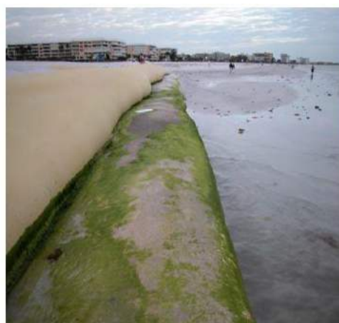
Hình 3.79: Thực trạng thi công Stabiplate tại Đồi Dương – Phan Thiết.
