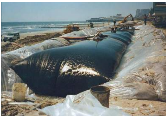
Hình 3.76: Quá trình thi công ống cát (trái) và sau một thời gian đưa vào sử dụng (phải) tại thành phố Atlantic bang New Jersey-Mỹ
