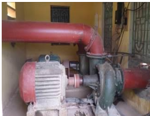
Hình 2.3. Trạm bơm tưới khu thí nghiệm
