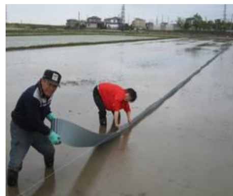
Hình 2.4. Thi công bờ bao ô thí nghiệm
